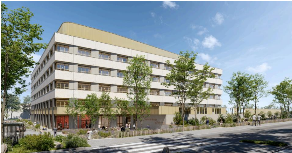
Institut de biologie et de pathologie ©TLR Architecture et Celnikier&Grabli Architectes
