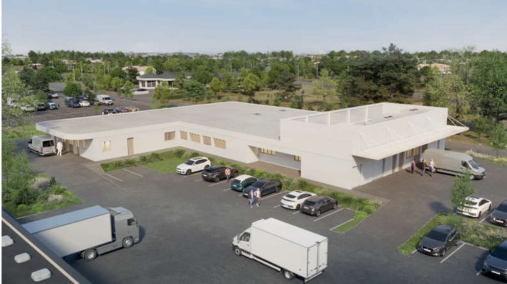
Le projet 1370 m2 Marché de conception réalisation avec MAS BTP, retenu en février 2022.
